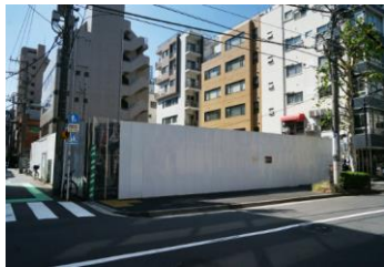
旧和泉町ポンプ所跡地
